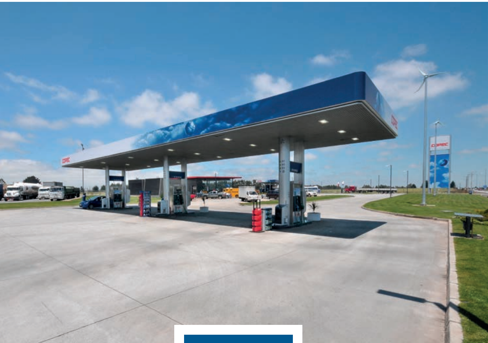
ESTACIÓN DE SERVICIO Ruta 5 Sur Km. 614, Victoria
